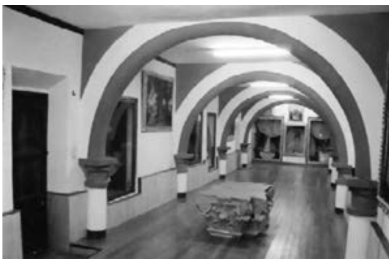
Celdas unidas, se han dejado evidencias de las paredes que las separaban
