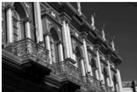
Fachada Segundo piso
